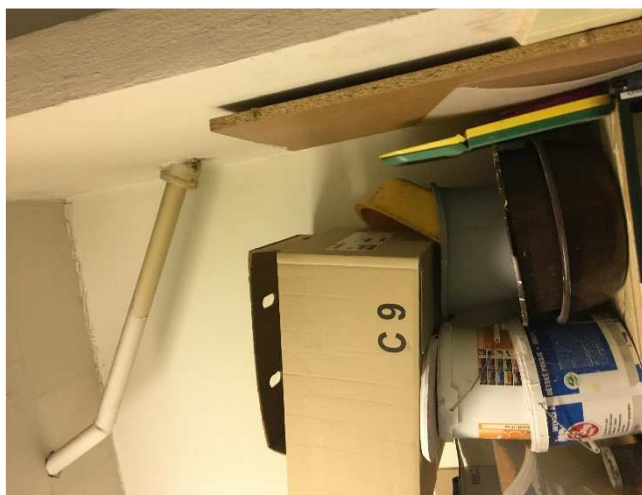
1.NP – kanalizační potrubí od vpusti ve 2.NP
